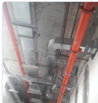
تمديد شبكات أنابيب إطفاء الحريق المعلقة ومجاري الهواء بالأسقف
