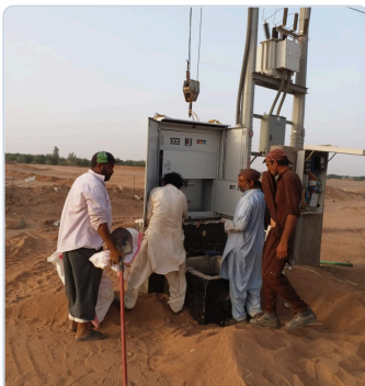
أعمال سحب وتمديد كابلات القوى وتوصيل اللوحات الكهربائية الميدانية
